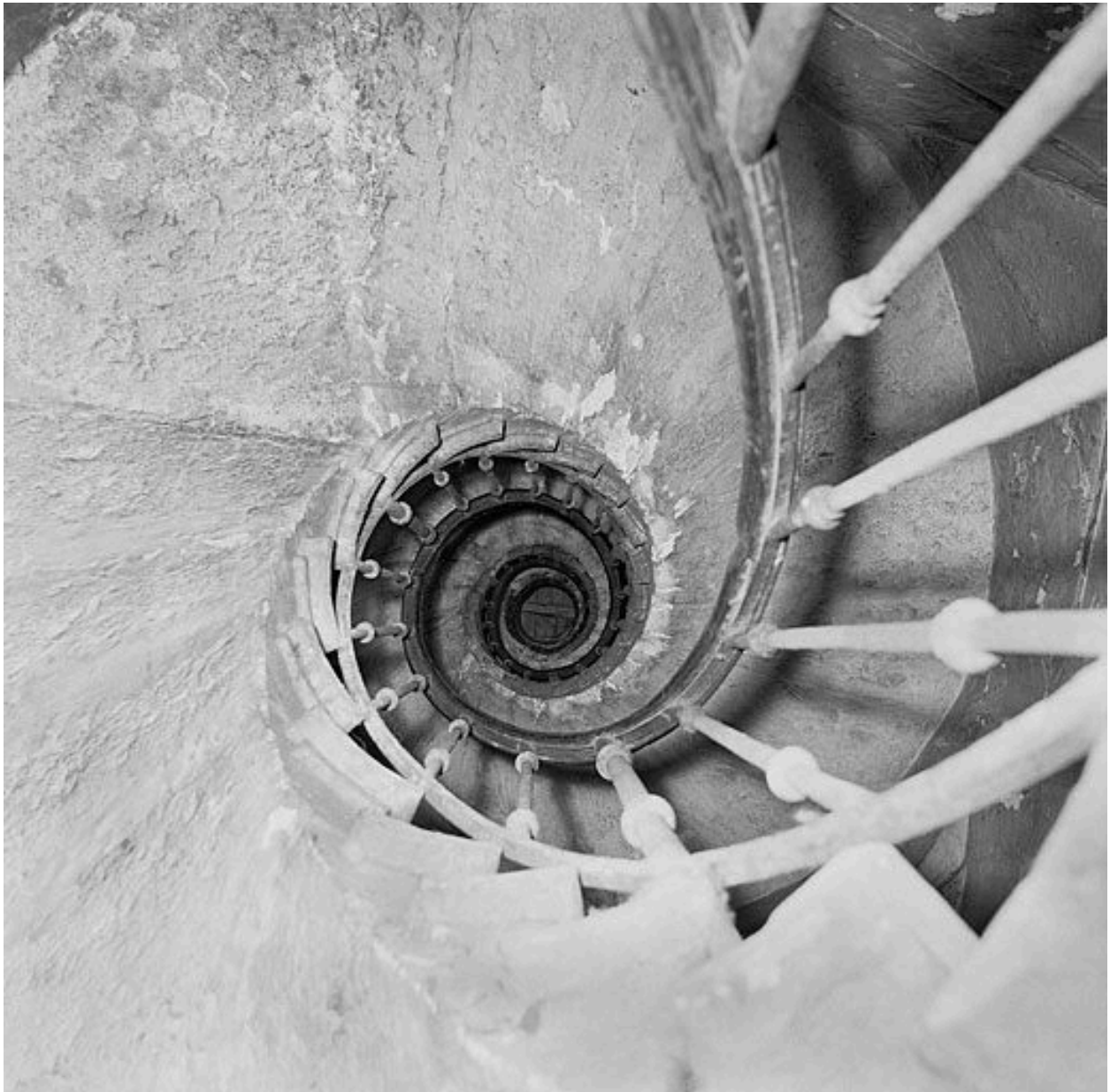
Vue en contre-plongée de l'escalier en vis suspendu
