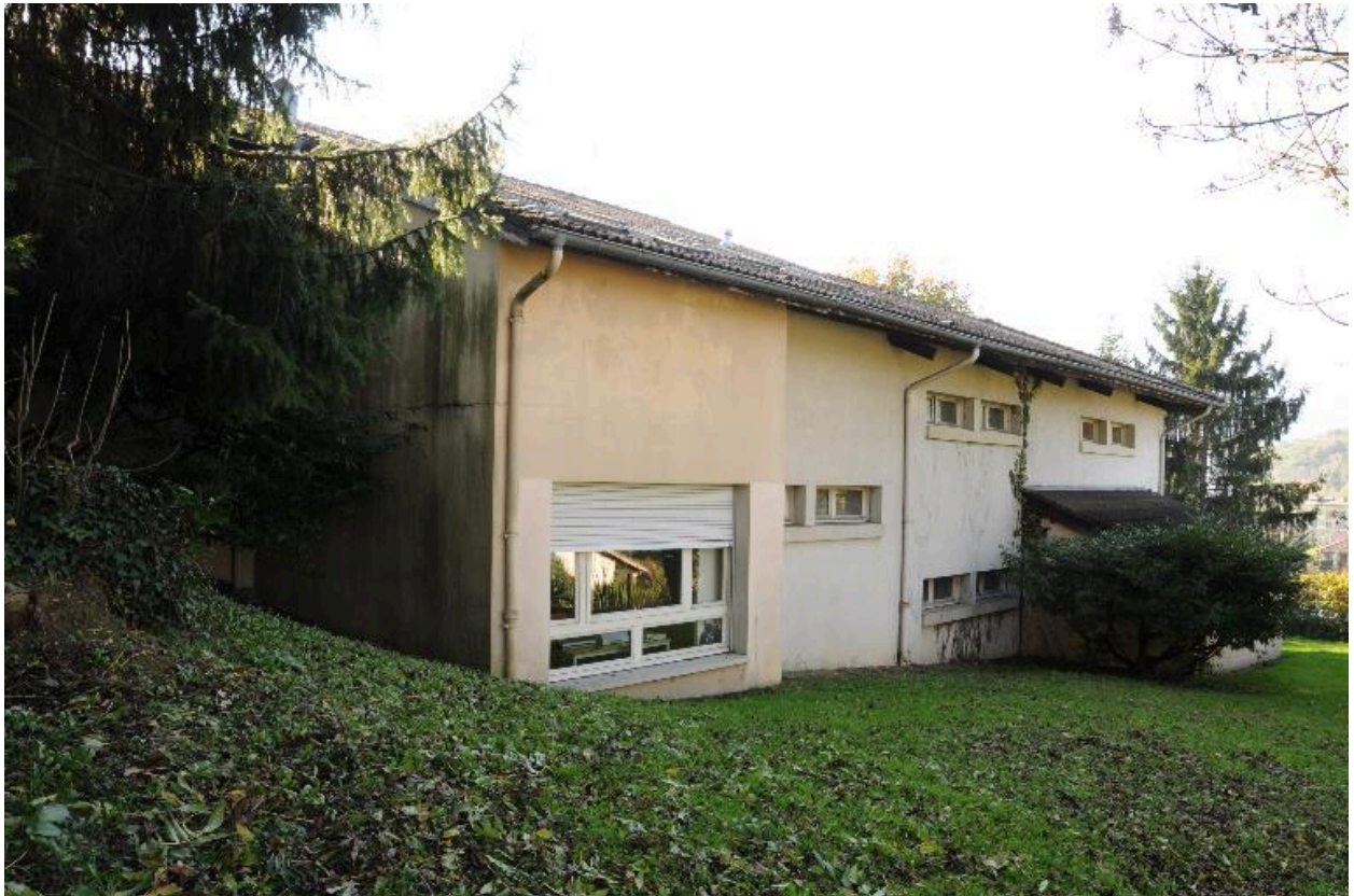
Façades postérieures nord
