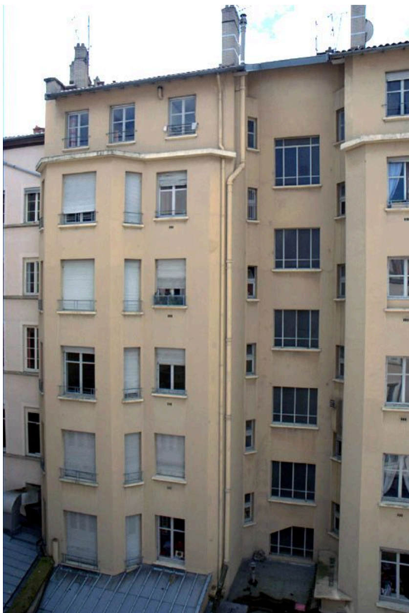
Élévation postérieure, partie orientale
