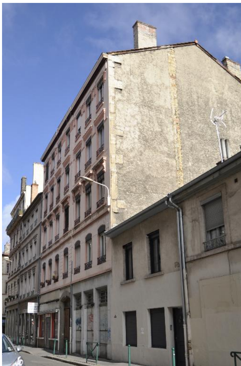
Elévation sur rue, vue générale
