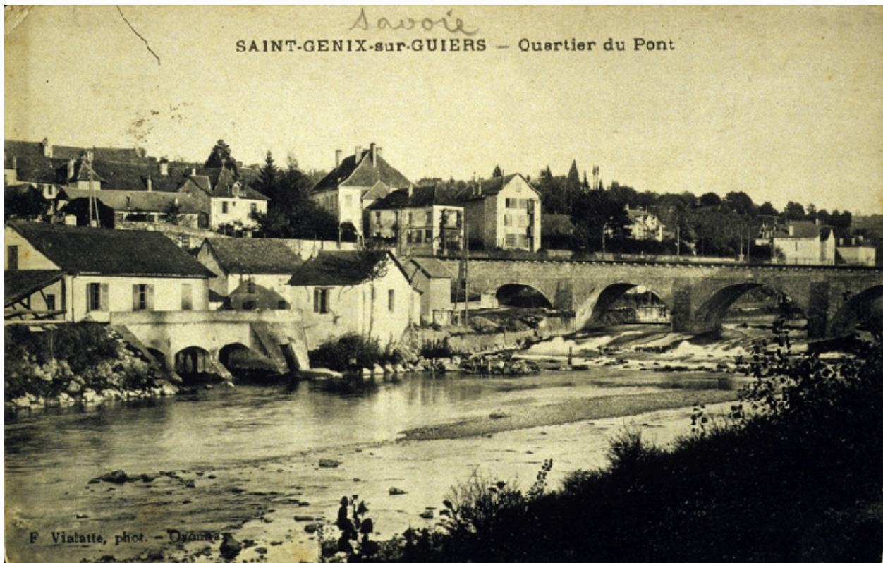
Centrale hydroélectrique, début du 20e siècle
