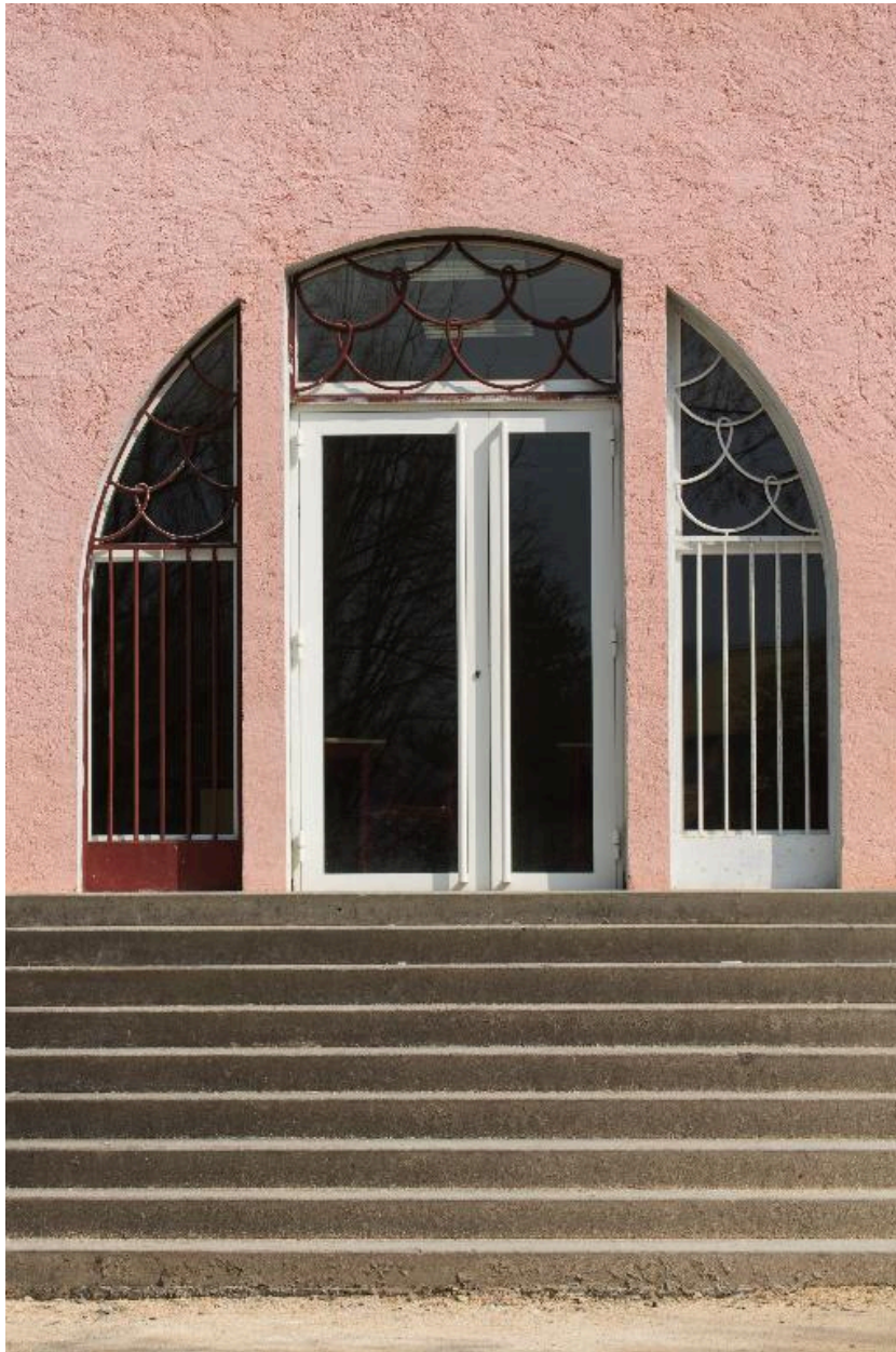
Bât. A : baie du couloir de distribution
