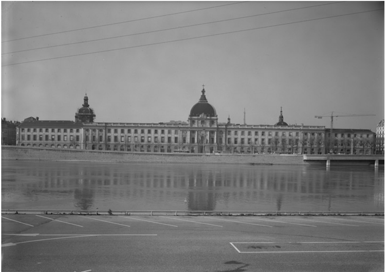
Elévation sur le quai du Rhône depuis la rive gauche. Photogr. 1979
