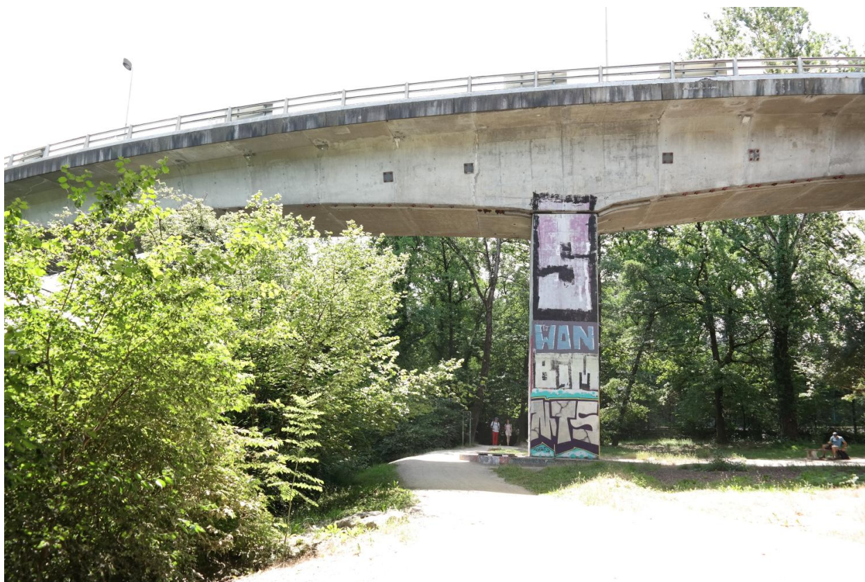
Viaduc de Cran, vue de la bretelle
