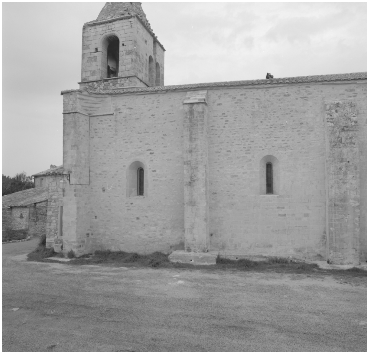
Elévation sud, détail : encorbellement dans l'angle sud-ouest.
