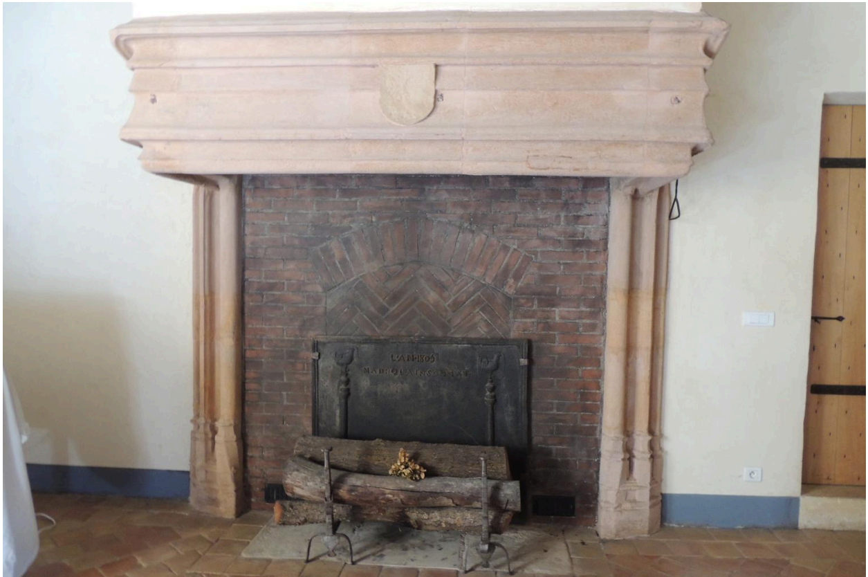
Manteau de cheminée, vue d'ensemble.
