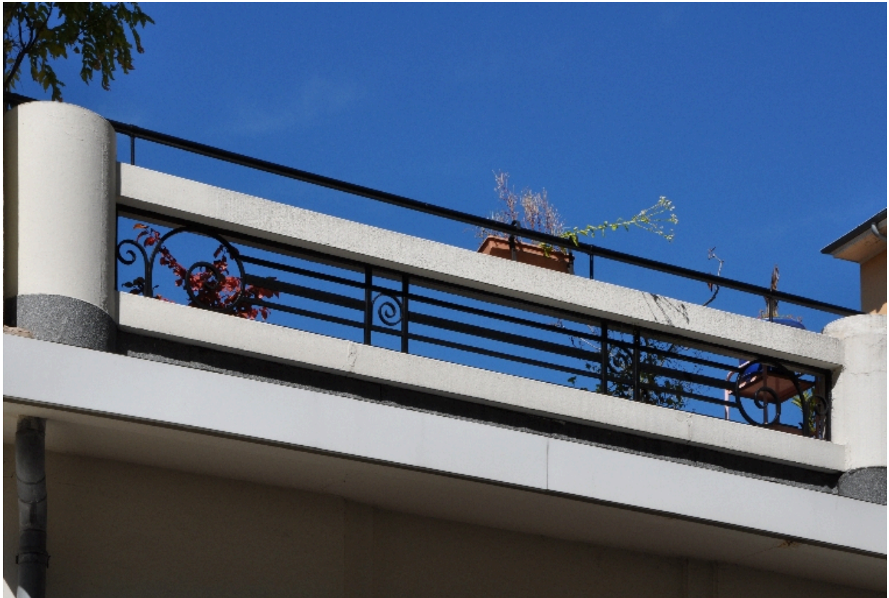
Garde-corps de la terrasse
