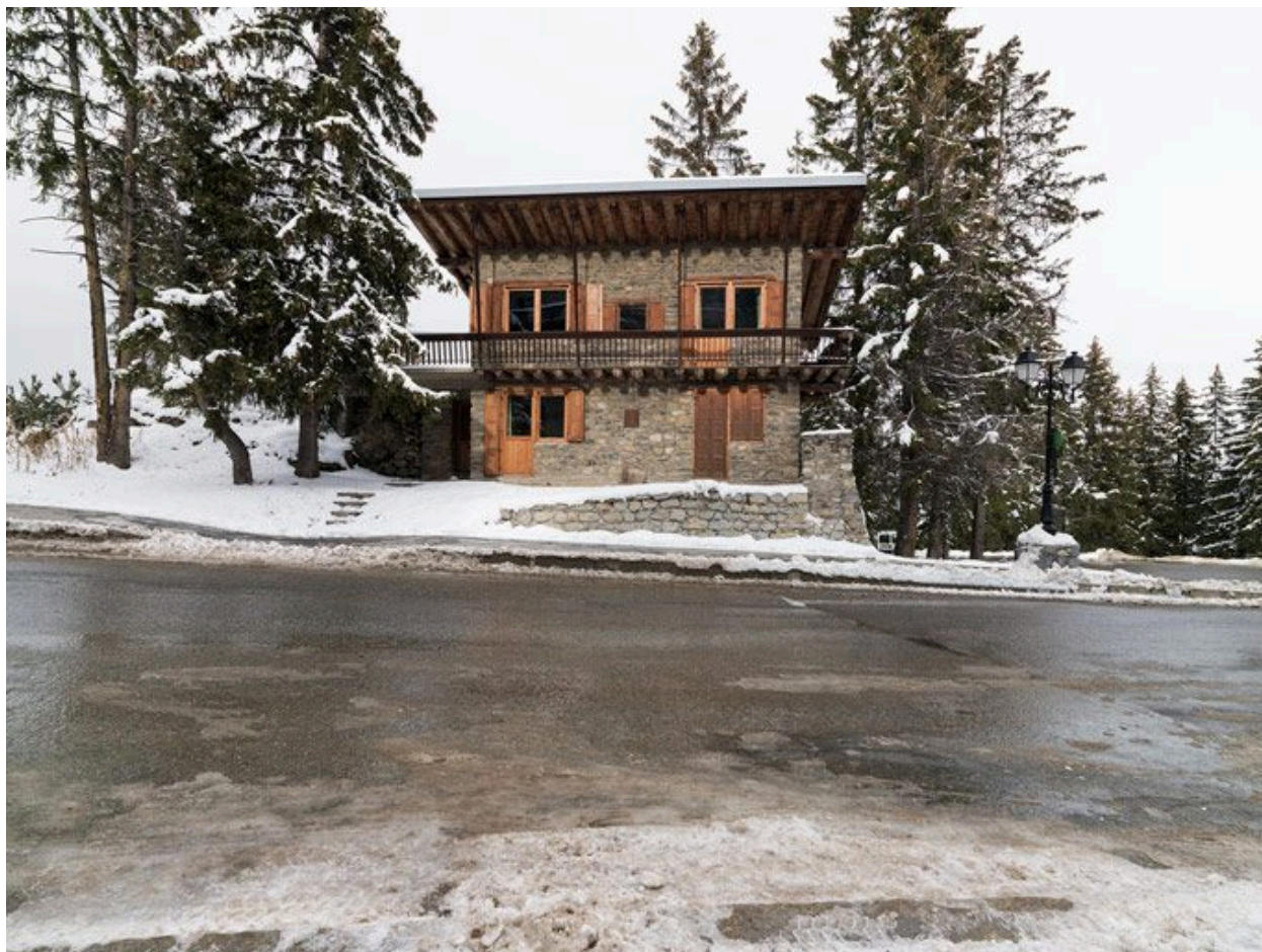
Elévation principale à l'est
