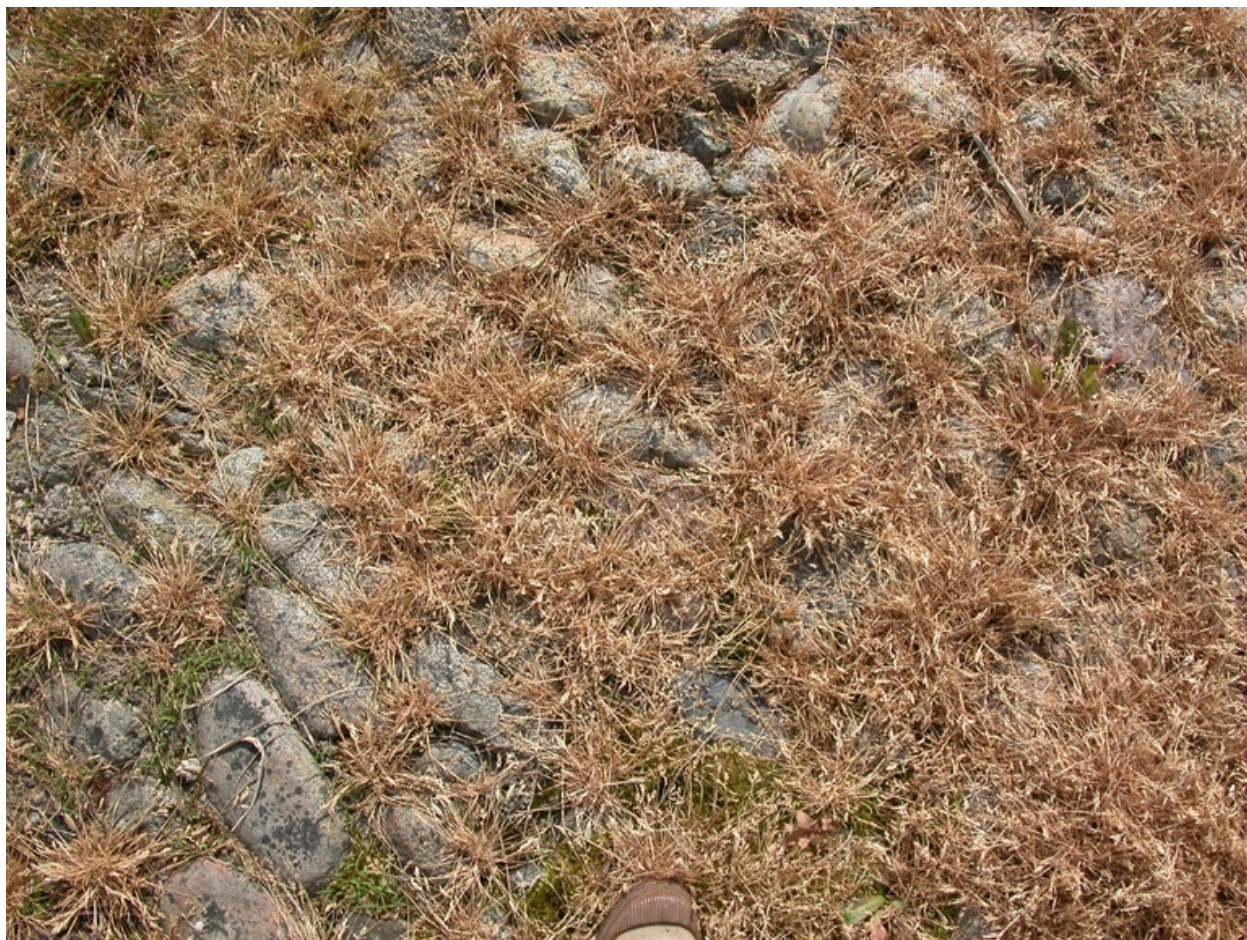
Détail du sol de la cour : pavage de galets.
