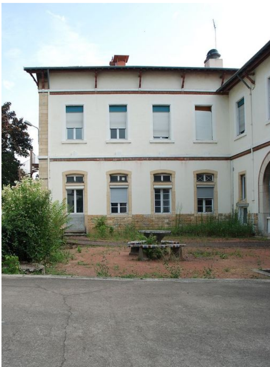
Façade principale (ouest), aile latérale nord
