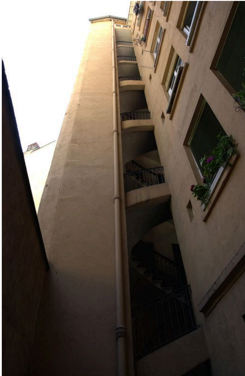
Cour, vue générale de la cage d'escalier
