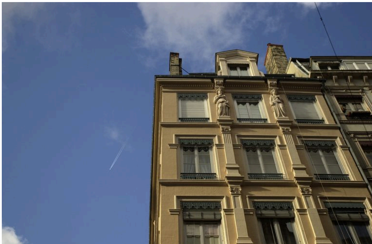
Elévation antérieure : vue partielle
