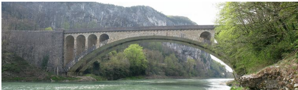
Vue panoramique, face amont
