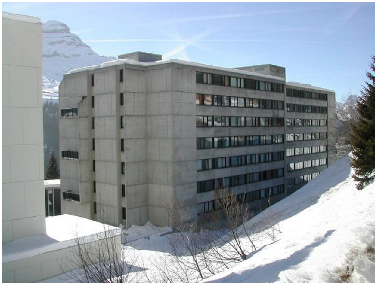
Elévation postérieure et pignon est
