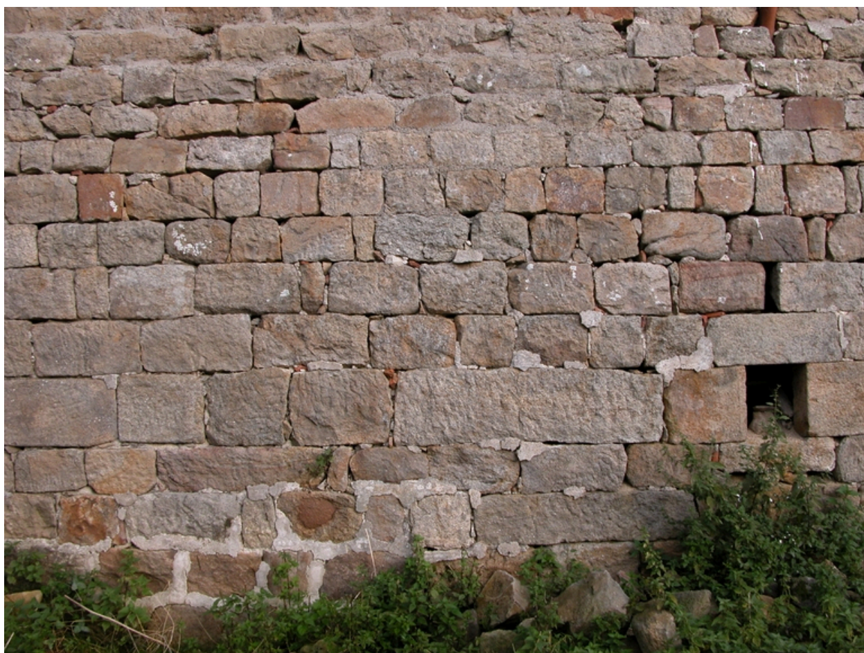
Ferme à Glizieux (non repérée, 1986 AC 13) : détail d'appareillage.
