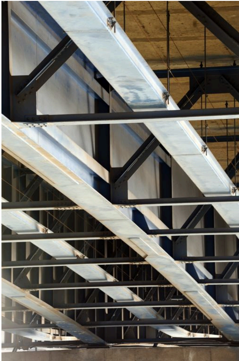
Dessous du tablier, vue de détail : structure (depuis la rive droite)
