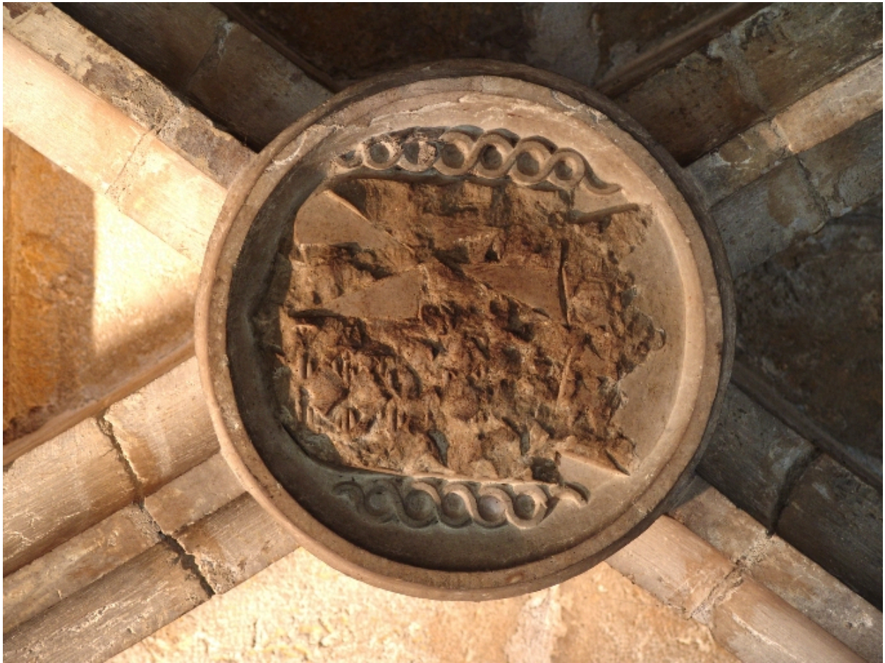
Grand escalier : clef de voûte du 3e niveau
