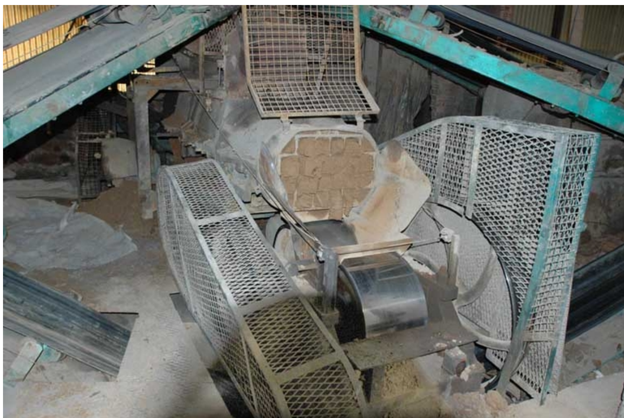
Vue d'ensemble : machine
