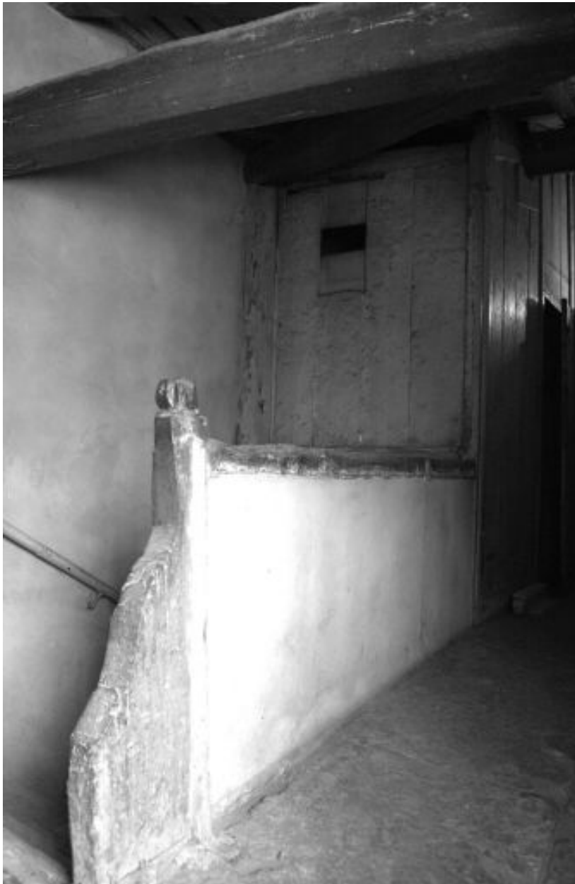
Escalier, palier du dernier étage
