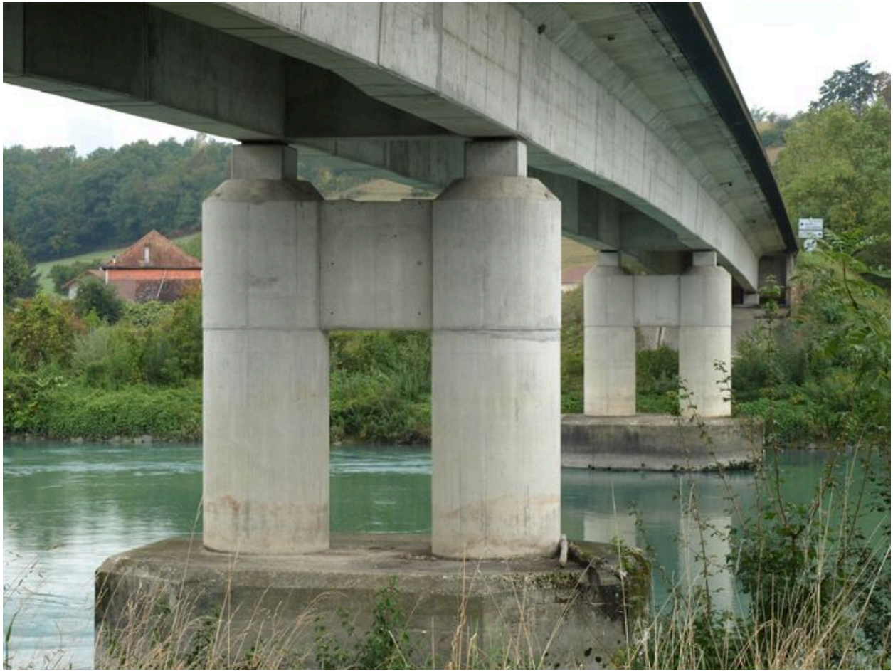
Piles, face amont (depuis la rive gauche)
