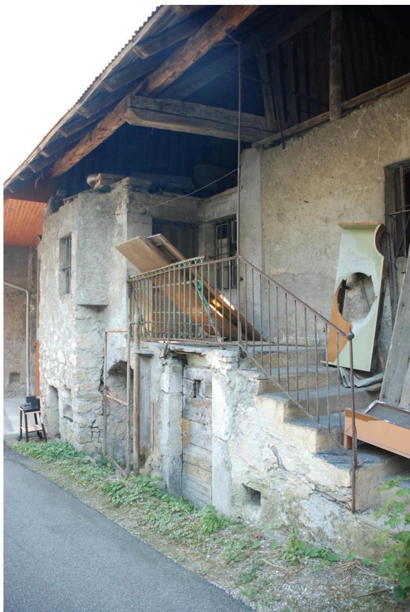
Maisons de vigneron (2018 I1 1663, 136), vue nord.
