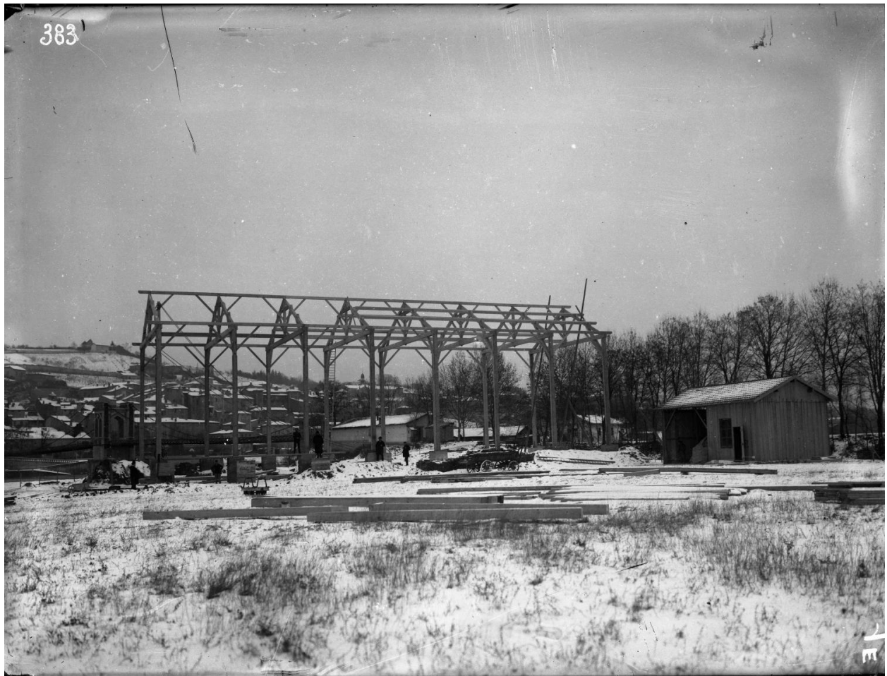
Vue générale de l'usine, AD 69 : série 158 J. plaque de verre, usine Tréfimétaux AD Rhône. 158 J
