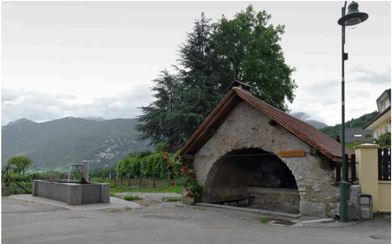
Vue générale après restauration.
