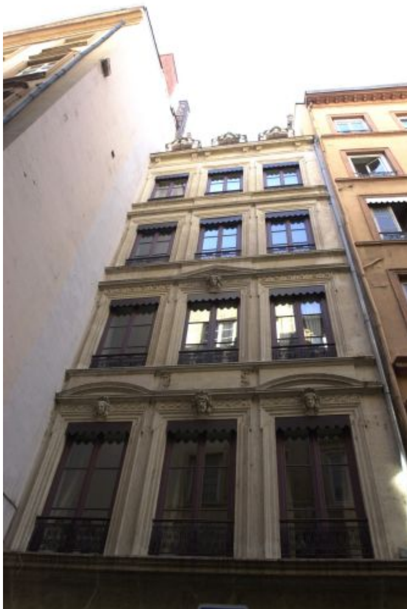
Façade rue Longue, vue générale par-dessous
