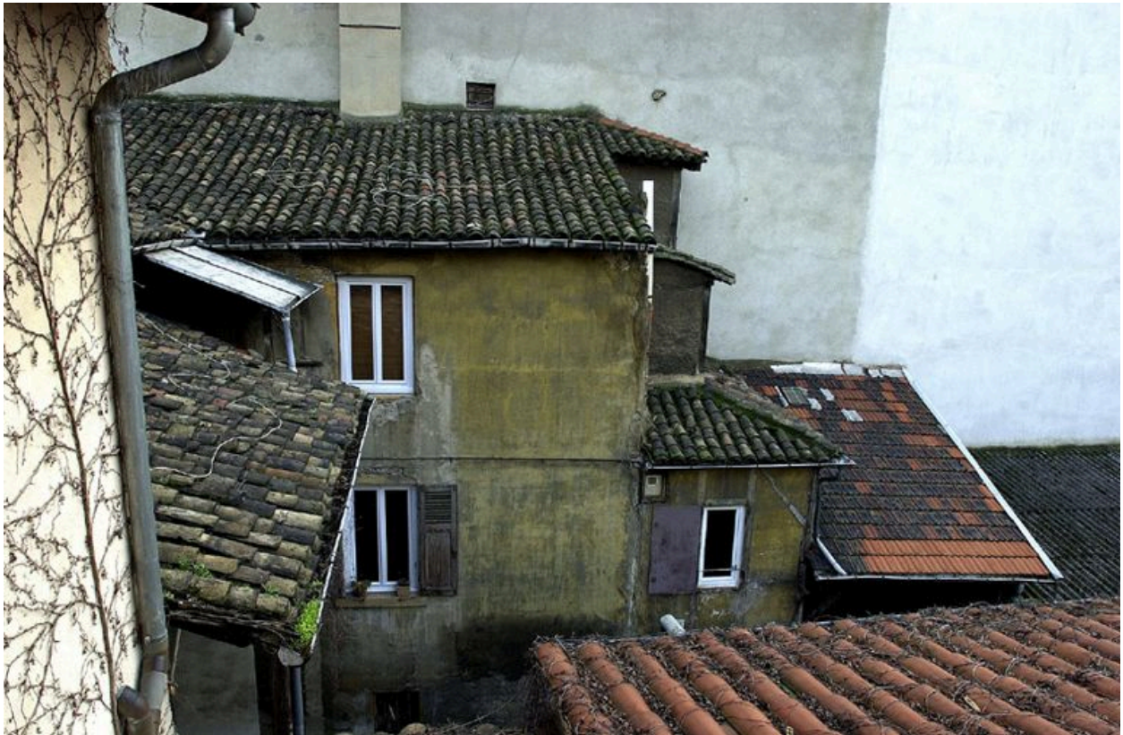
Vue de la maison en pan de bois, à l'est de la cour
