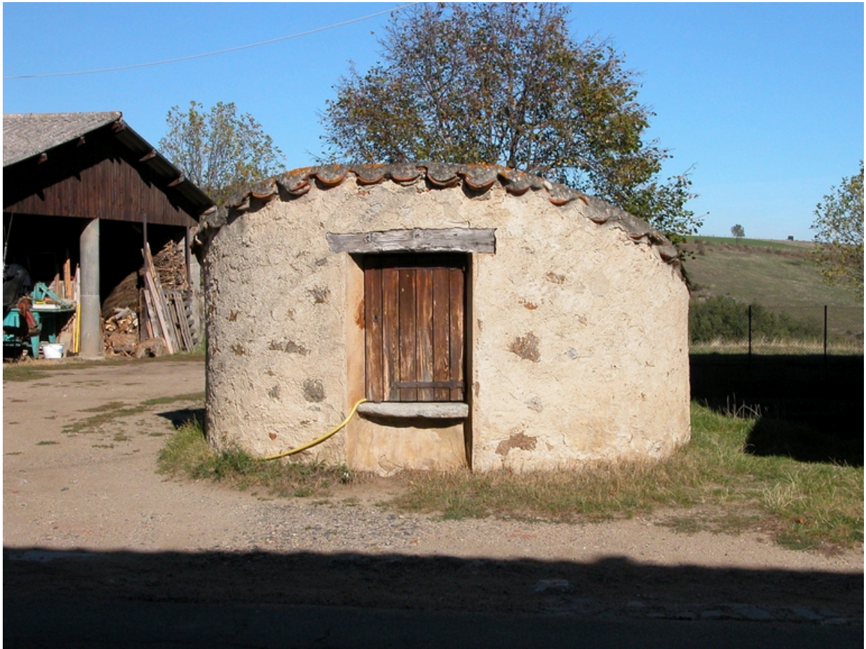
Puits à Faury (1986 B 276 a).
