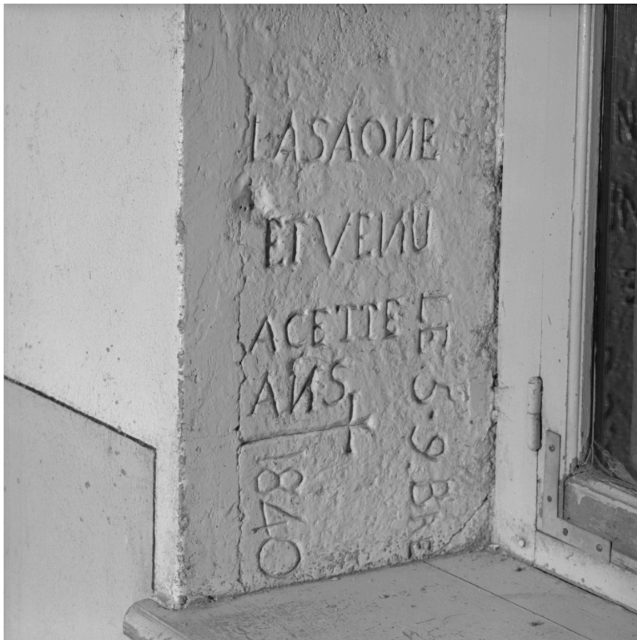
Ferme de type A, située à Trévoux, au lieu dit le Grand Champ, parcelle AO 36. Tableau de la fenêtre de la cuisine : inscription montrant le niveau de la crue de la Saône en 1840.
