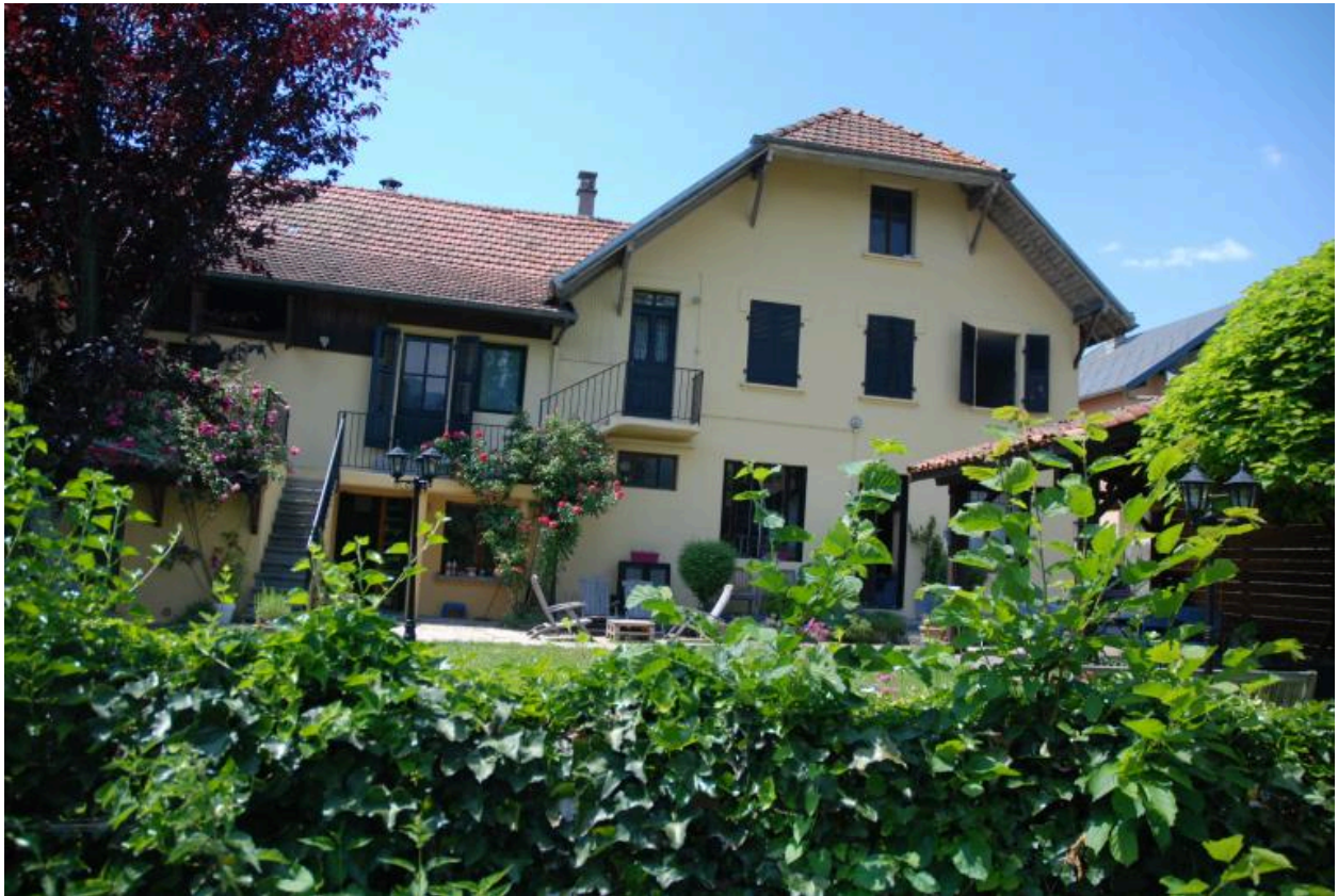
Hôtel Tilliet, puis maison (2016 A6 404, non repéré). Vue arrière.
