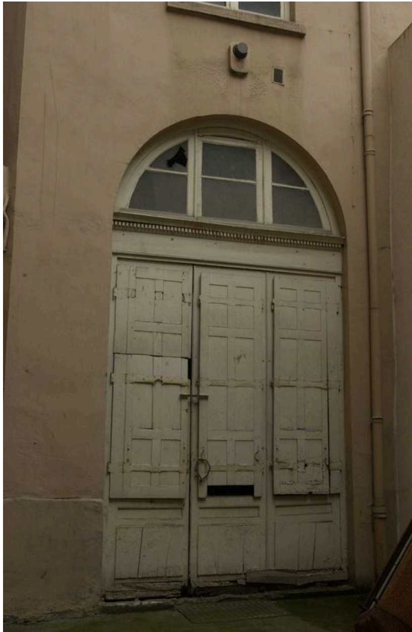
Porte à vantaux de bois ouvrant sur la cour
