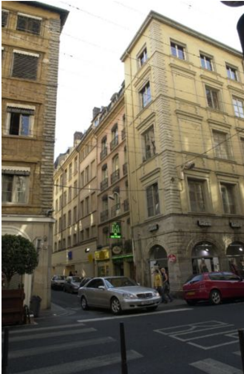
Angles des immeubles du 17e siècle, 9 rue Dubois à gauche, et 15 rue de Brest à droite
