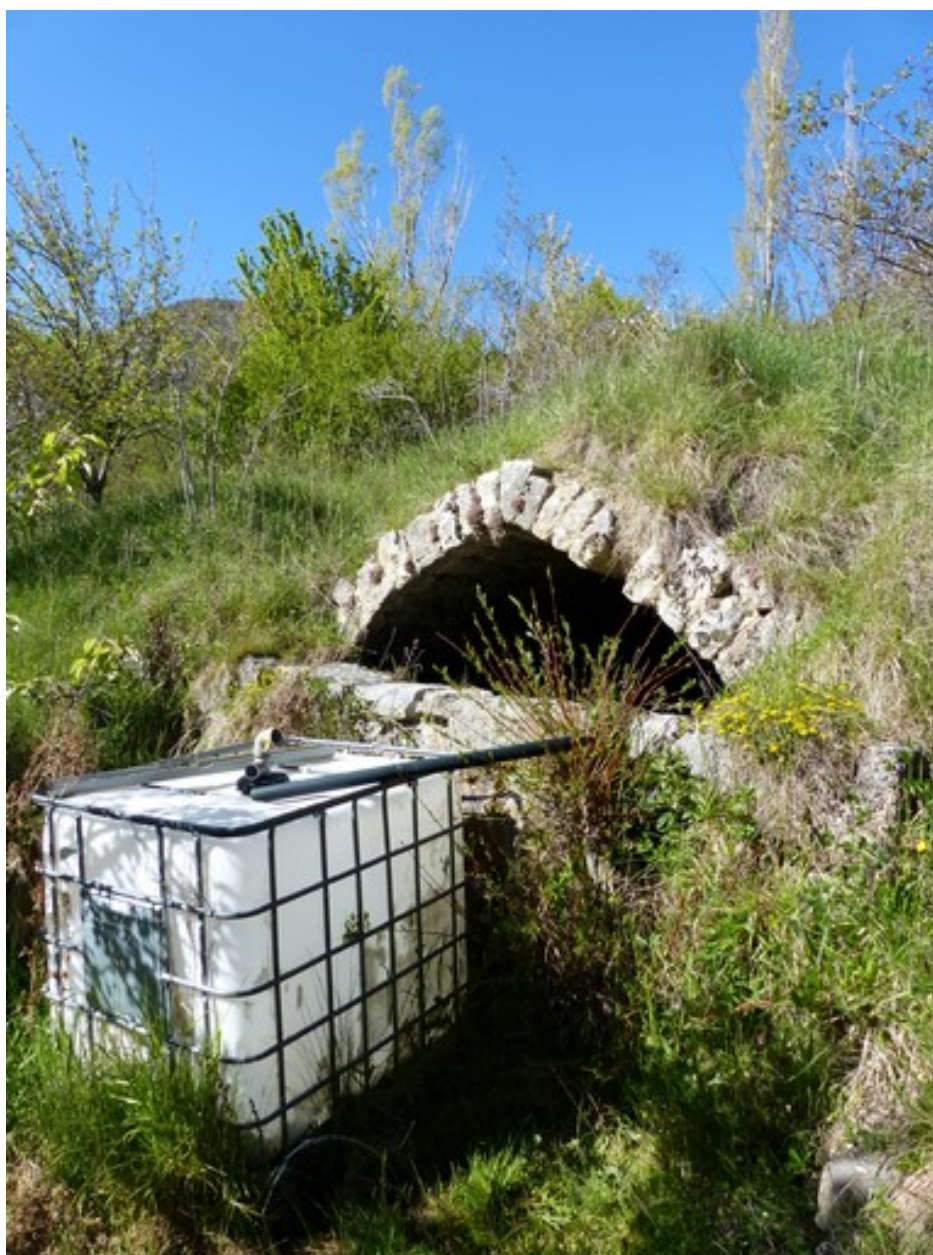
Réservoir sous voûte, ferme au quartier des Routes.
