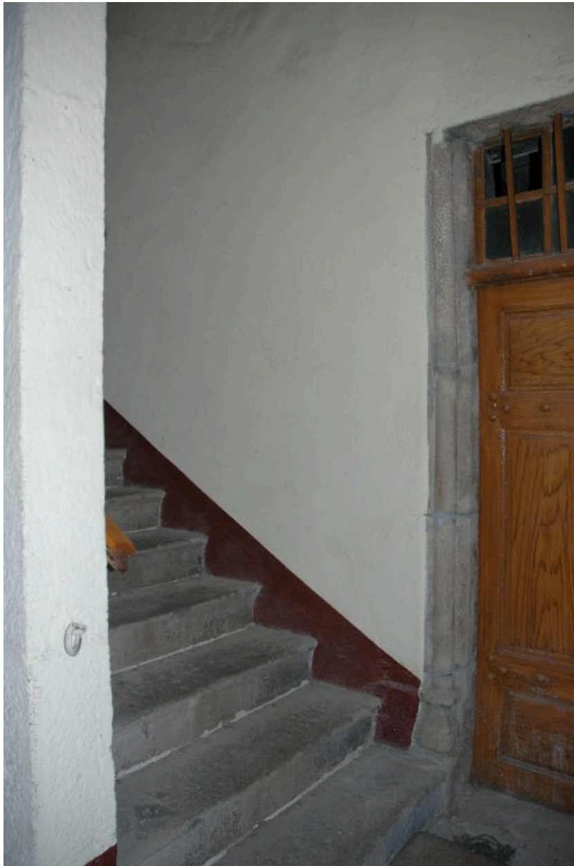
Vue partielle de l'escalier du 17e siècle (?) et encadrement de porte mouluré sur base prismatique du 16e siècle.
