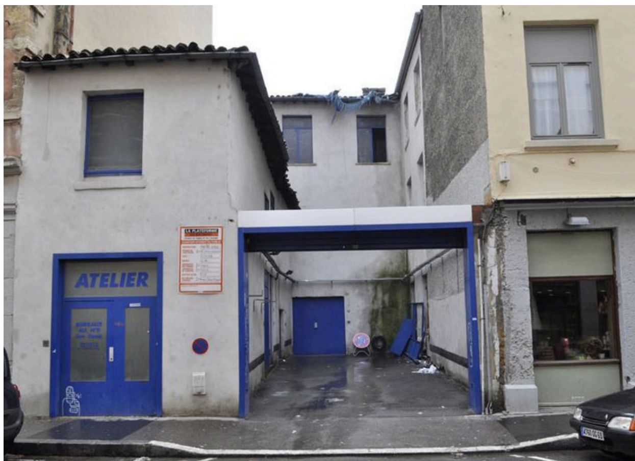
Ancien atelier démoli en 2010.
