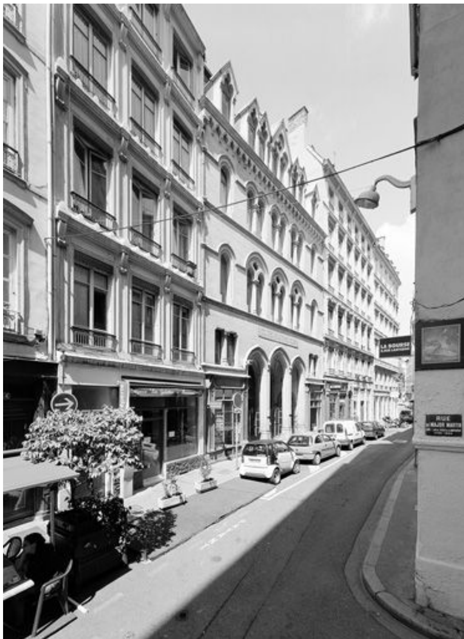
Vue générale de la façade
