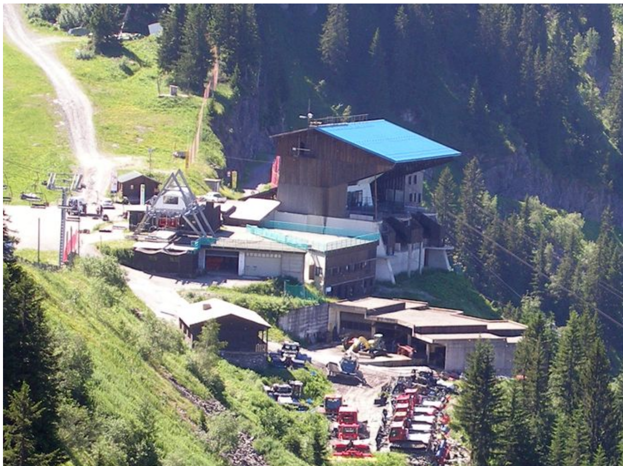
La gare supérieure depuis le nord-ouest
