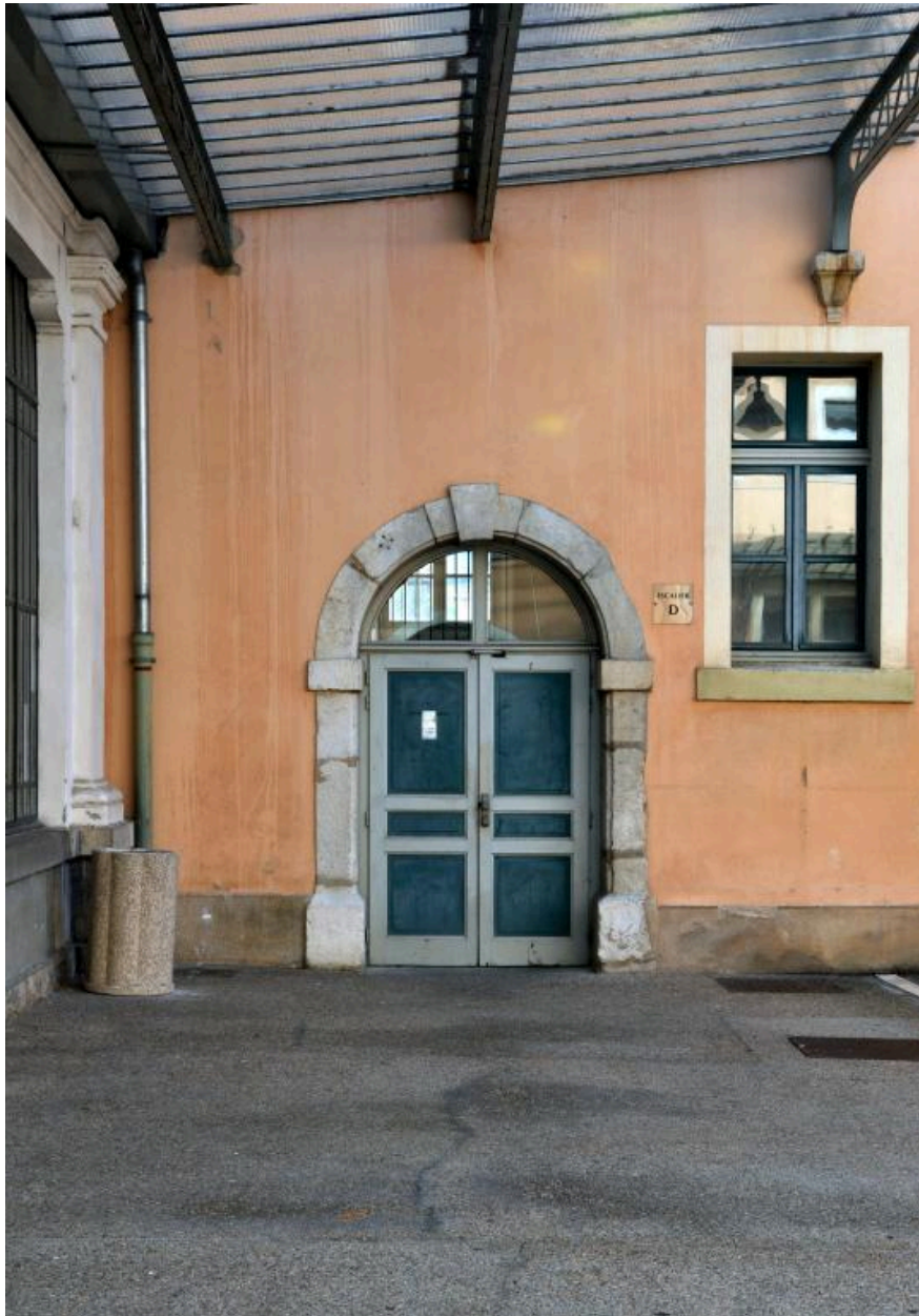
Bâtiment E : porte sur cour 2
