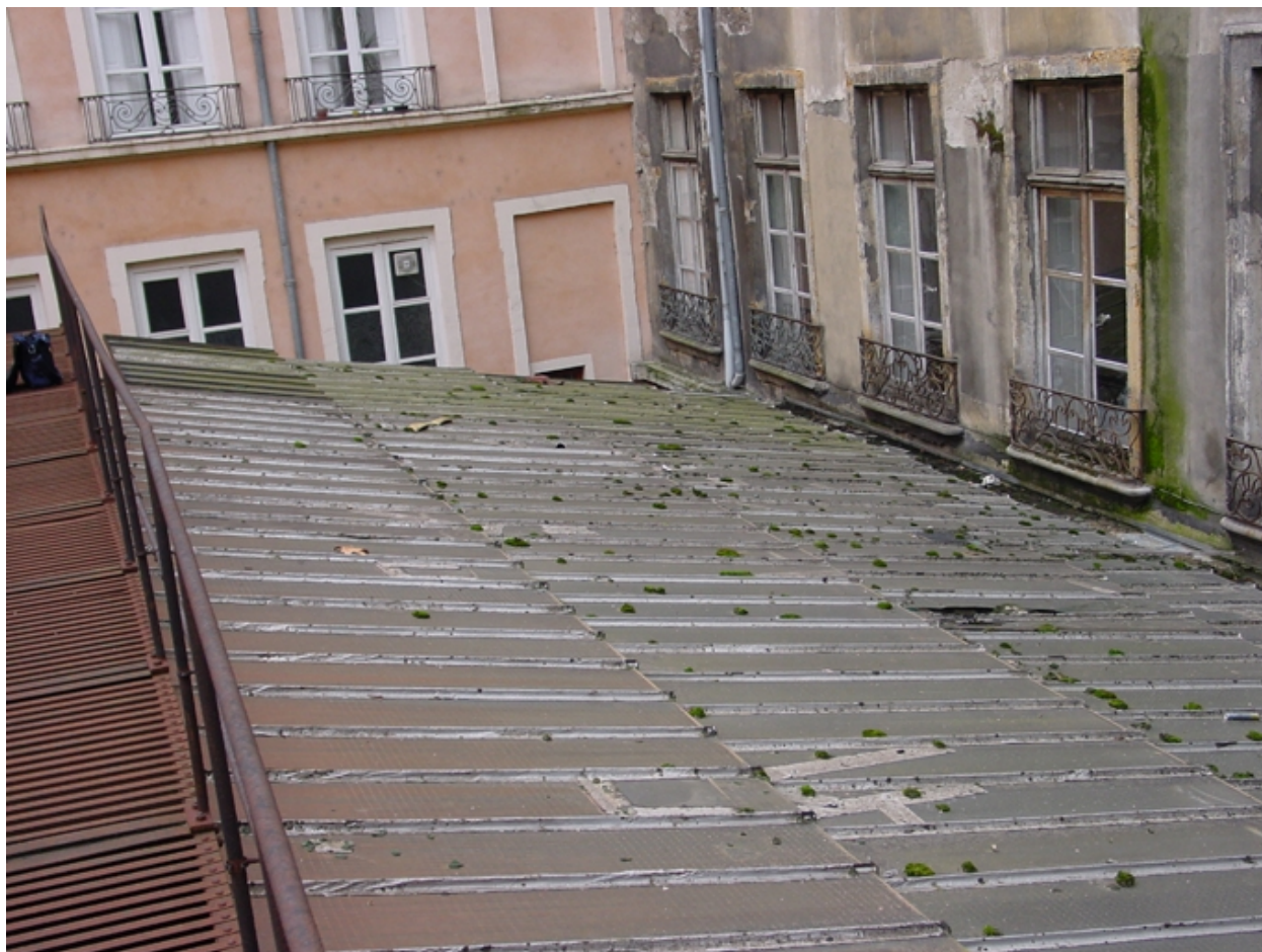
Détail toiture (verrière)
