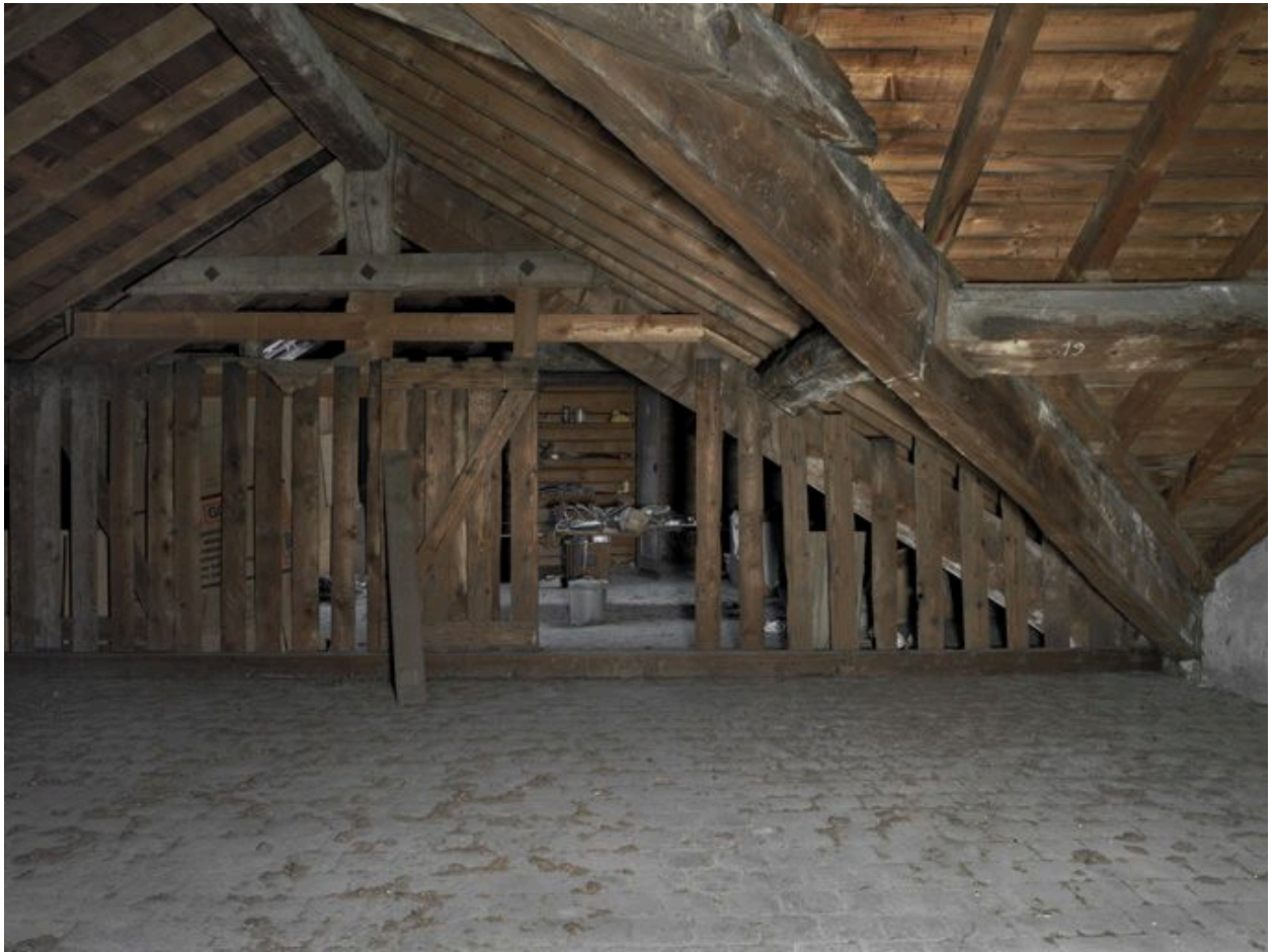
Comble, vu depuis l'est
