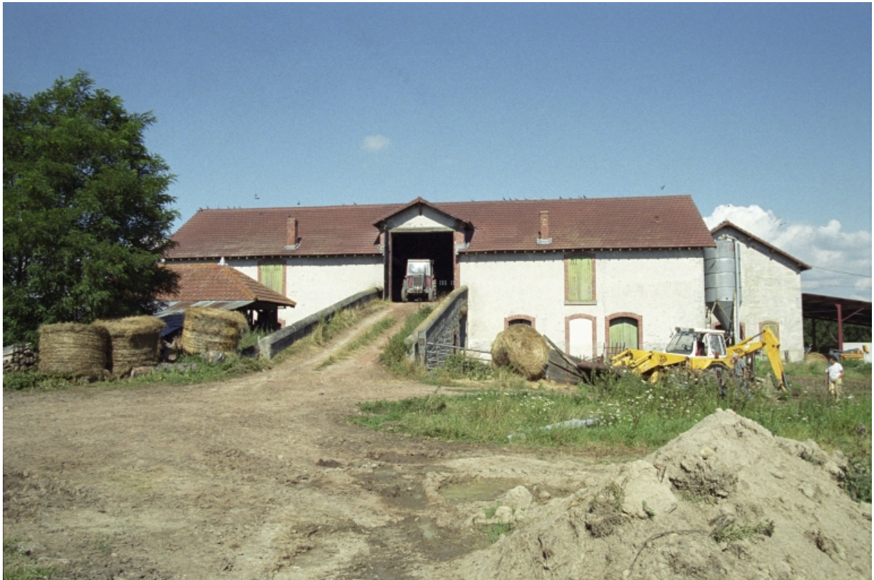
Vue d'ensemble de la façade postérieure de l'étable.
