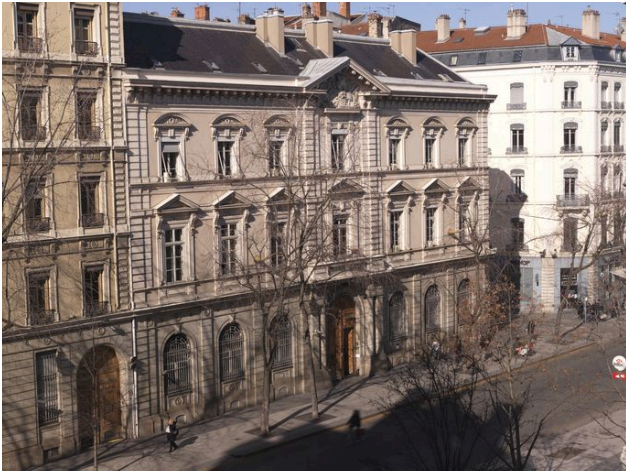
Vue de l'élévation située 14 rue de la République.
