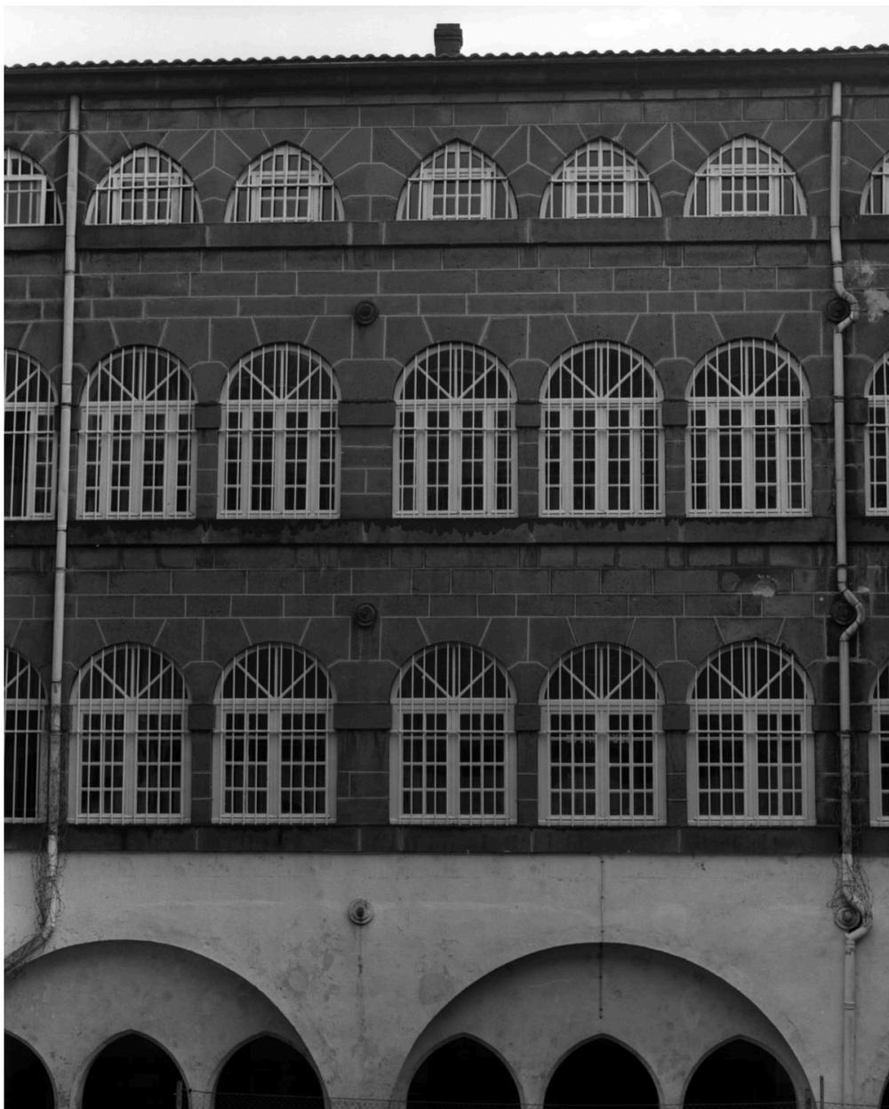
Cloître, élévation sud : les baies du quatrième niveau sont couvertes d'arcs brisés, contrairement aux trois autres élévations, indiquant la présence de l'église de ce côté. Les ancrs font probablement partie de celles que Degeorge proposait d'introduire dans la construction en 1828.
