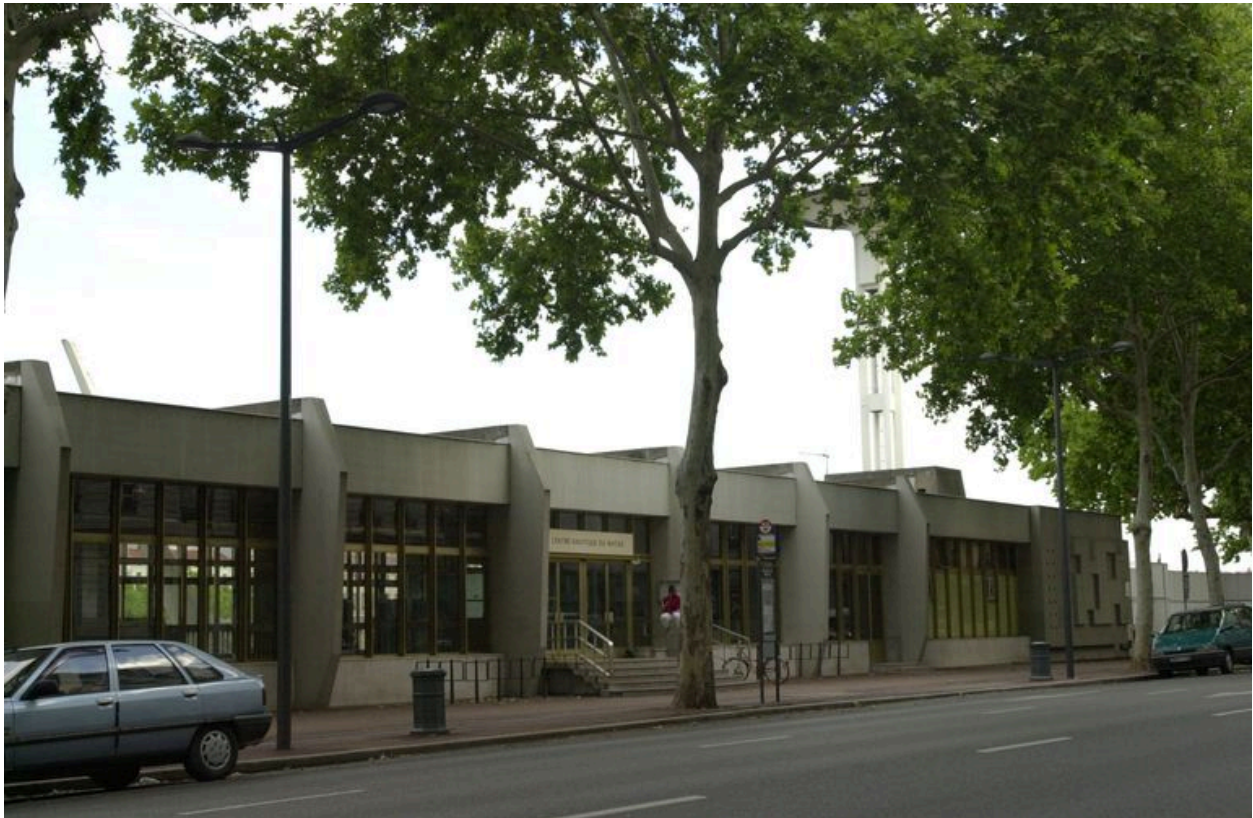
Le bâtiment d'exploitation depuis le sud-est
