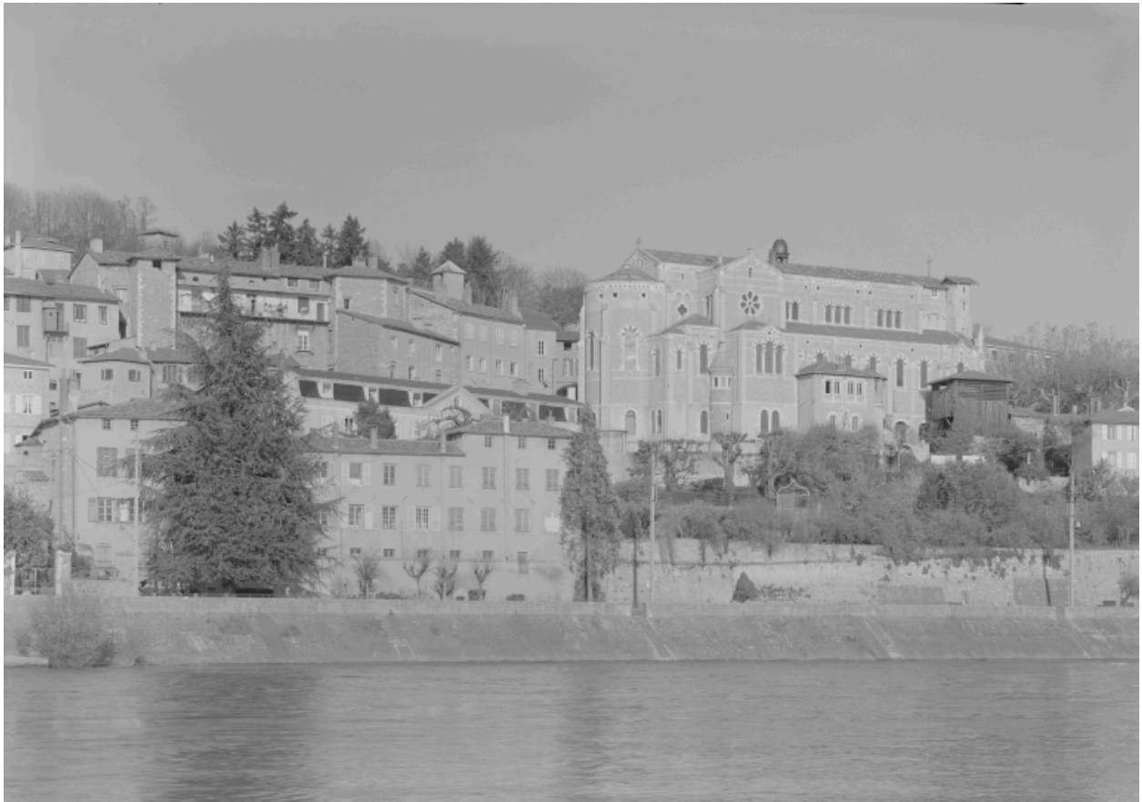
Vue du sud-ouest.
