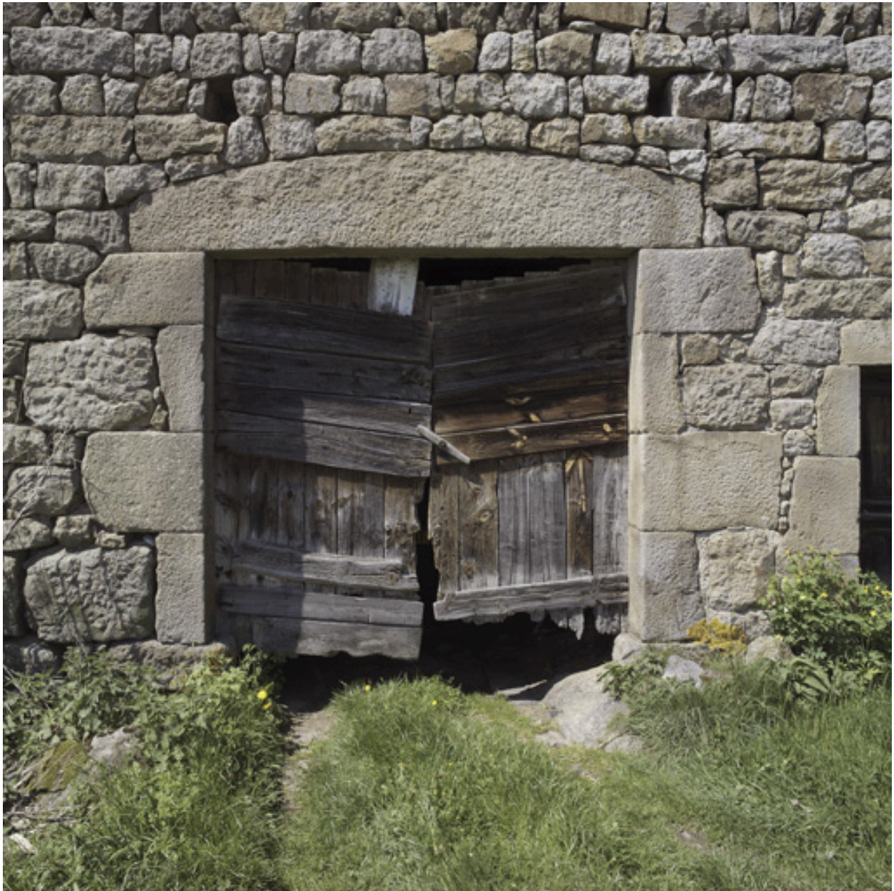
Détail de la porte de la grange.
