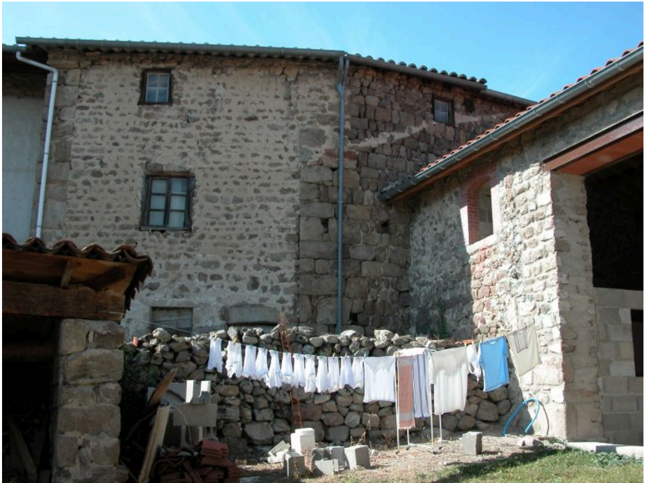
Vue de l'angle du logis 2 et de la grange-étable nord, depuis le sud-est (état en 2011).
