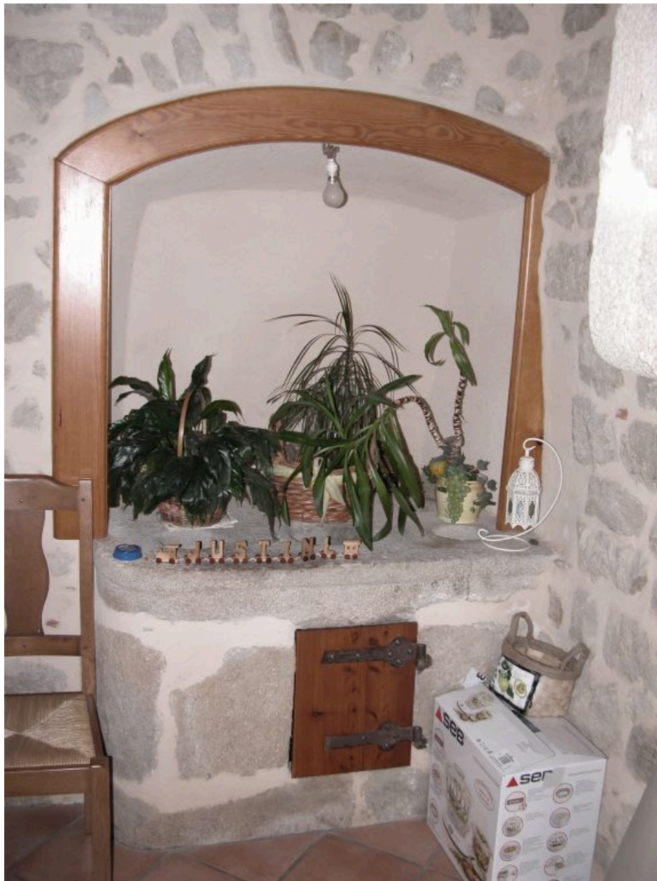
Aile nord de la maison forte, vue d'ensemble du potager de la cuisine.
